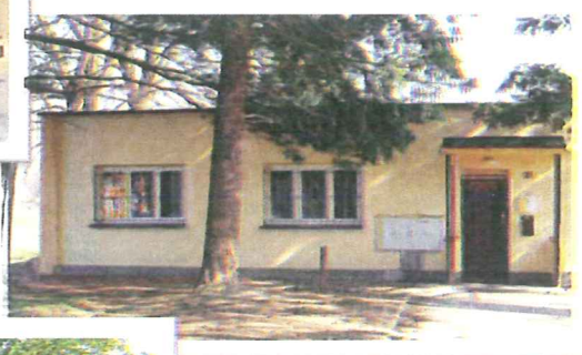
Budova B, 28. října 781
